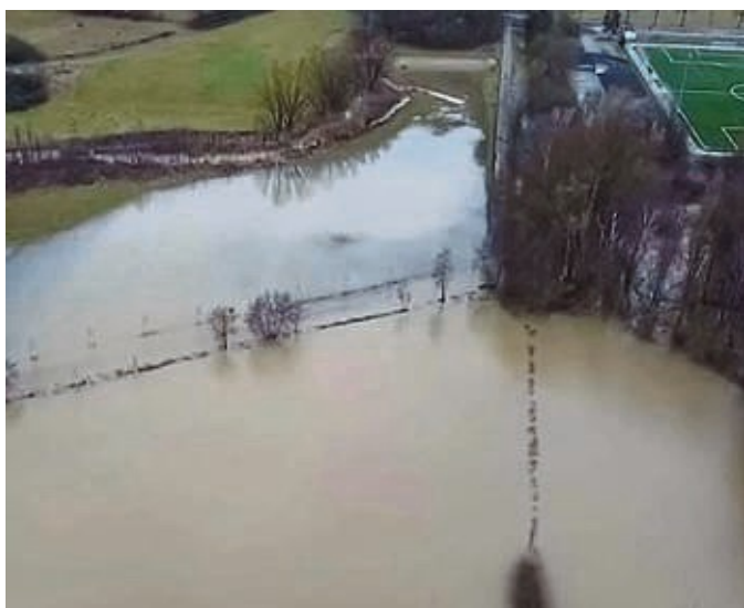
Land unter: Bruchköbel erlebt Ende Januar das größte Hochwasser der vergangenen Jahre. Doch die Keller bleiben trocken, auch dank der Investitionen in den Hochwasserschutz.
